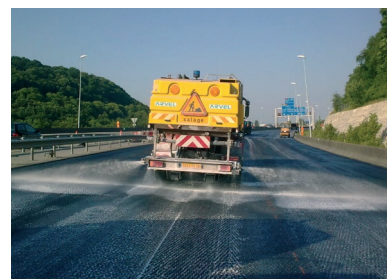
Epandage à la saumureuse d'Asphacal® TC
