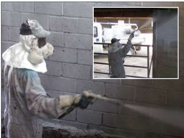
Figur 5: Eksempel på kalkning af stald med hvidtekalk. Hvidtekalk kan også påføres med kost eller ved anden egnet metode (Belgien).
